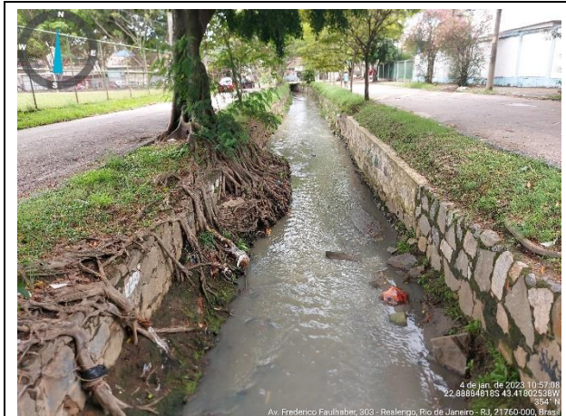
Figura 22 – Raízes danificando a canalização
