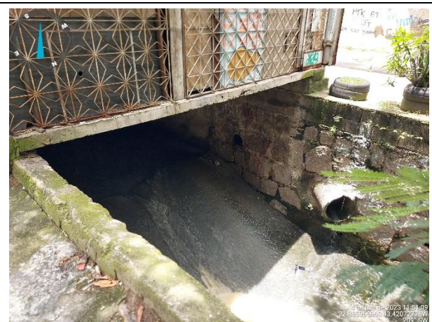
Figura 27 – Construção sobre a calha do rio
