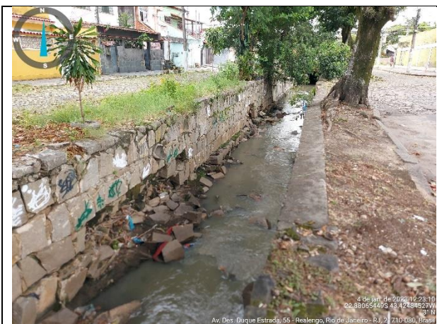
Figura 28 – Desmoronamento de canalização
