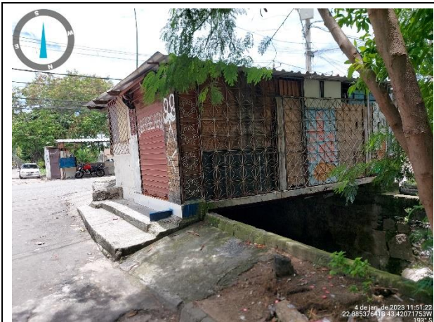
Figura 26 – Construção sobre a calha do rio
