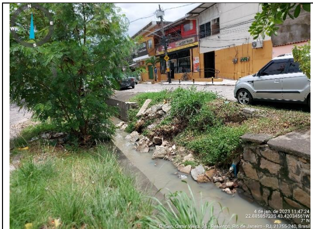
Figura 24 – Desmoronamento de canalização
